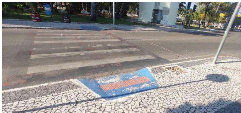
Figura 12 - Faixa de pedestre com o rebaixo do meio-fio
