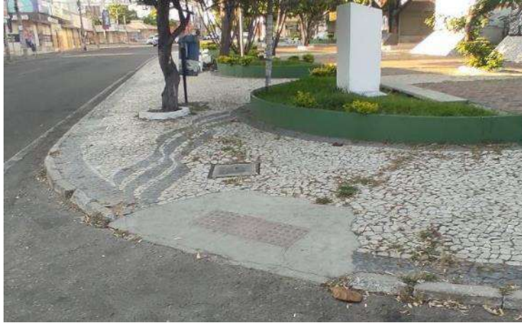
Figura 9 – Rebaixe da calçada com inconformidades
