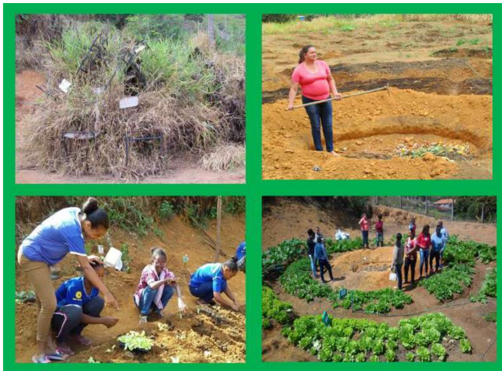
Imagem 02: Etapas de construção da horta
