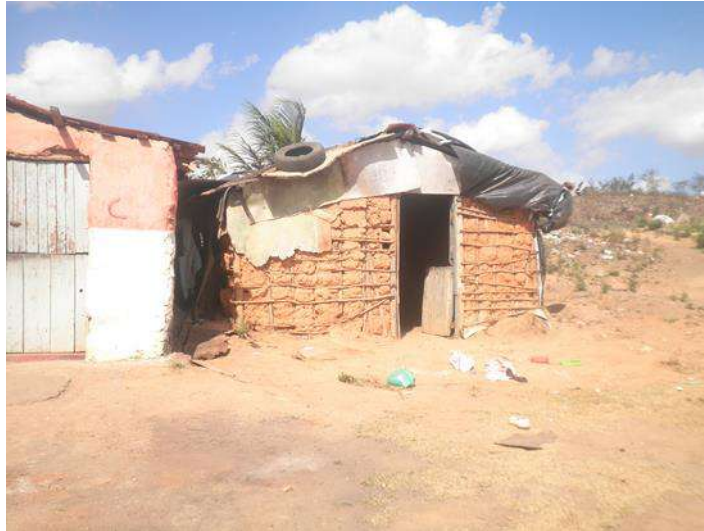
Figura 2 - Construção em taipa de mão ou pau-a-pique
